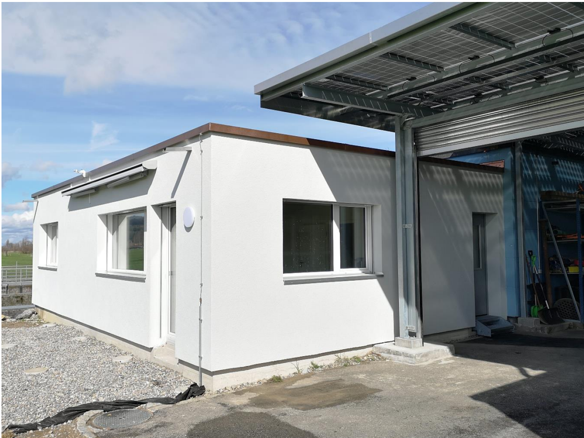
Aussenansicht Anbau Betriebsgebäude ARA
