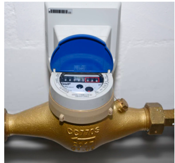
So sieht die Mönchaltorfer Wasseruhr aus. Die weisse Kiste hinten enthält das Funkmodul.
